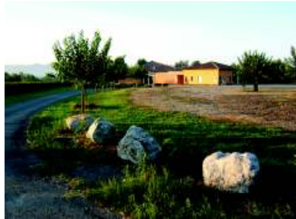
espaces de stationnement de la salle polyvalente
